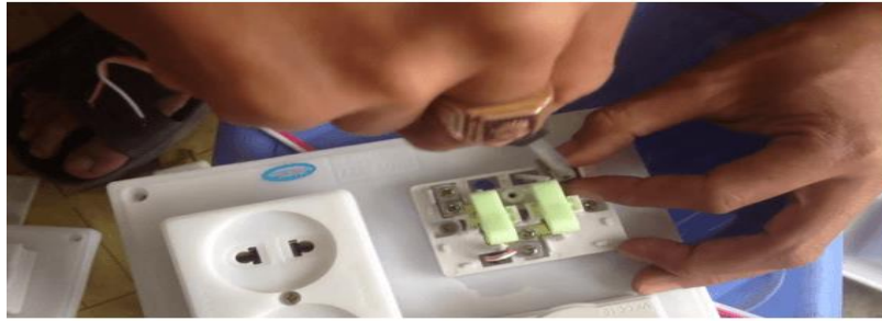
Hình 41. Lắp các thiết bị
